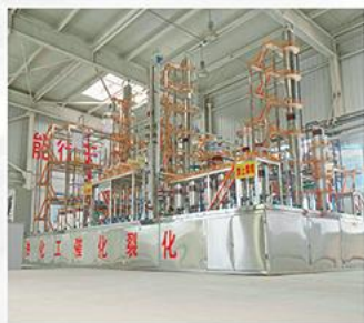
石油炼制工程实训实验室
